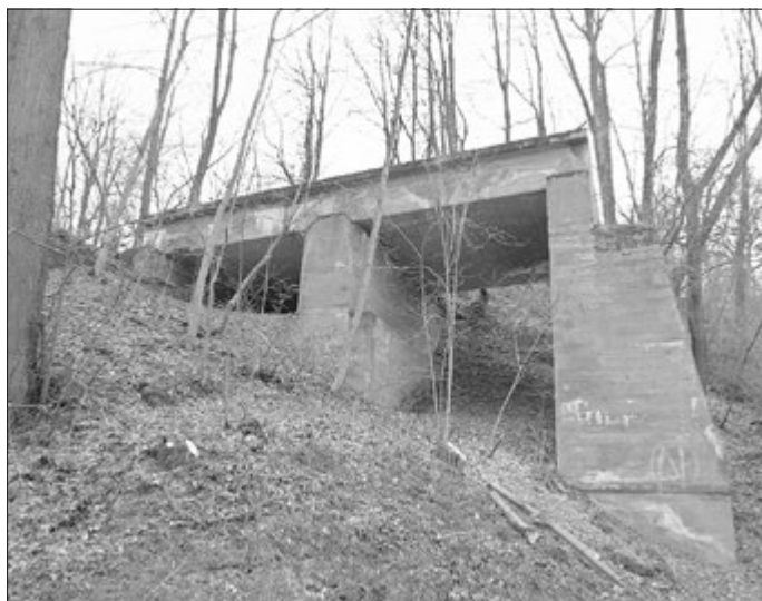
Eine der unvollendeten Reichsbahnanschlussbrücken (Ortsausgang Großbeutersdorf Richtung Eichenberg)
