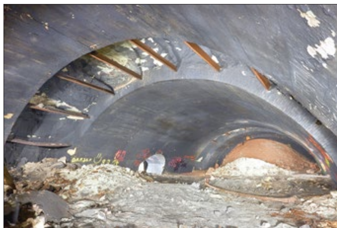
Einer der teilweise fertiggestellten Montagehallen/ links, mittig, der Personenzugang
