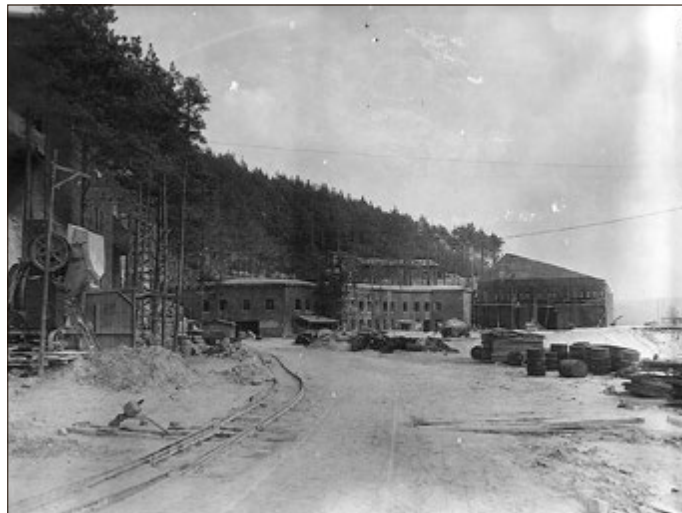
v.r.n.l.: Bunker 4, Werkstatt 1 und Teilsicht von Bunker 0, April 1945
