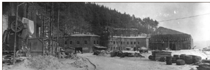
Zweistöckiger Werkstattbunker 1, zwischen Bunker 4 und 0
