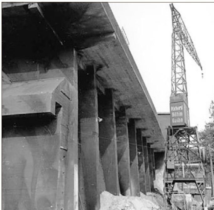
Vorderseite von Bunker 0, auch als „Böhm-Halle“ bekannt, da die Baufirma Richard Böhm/Gotha neben Dyckerhoff & Widmann/Nürnberg, hier die leitende Baufirma war.
