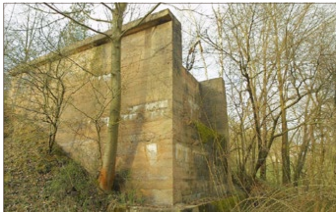
Einer der Brückenpfeiler bei Großbeutersdorf, Richtung Eichenberg
