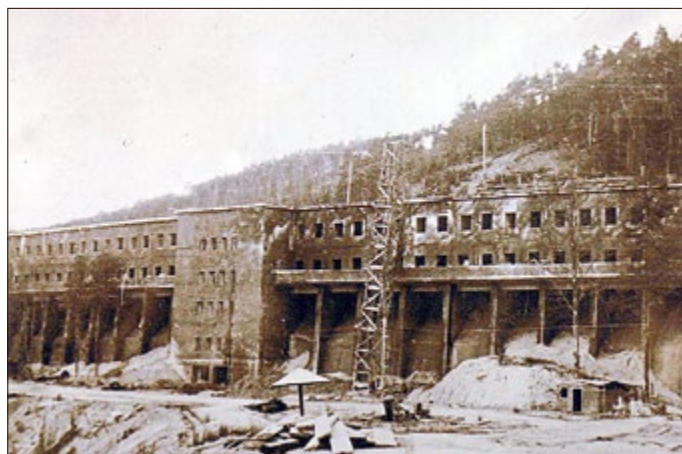
Bunker 0, Stützpfiler an der Außenseite für das aufgesetzte Betriebsgebäude
